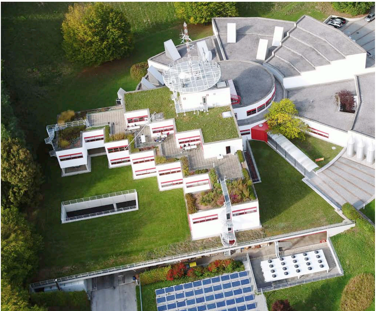
Seit April 2017 wird beim ORF Burgenland Sonnenstrom erzeugt
